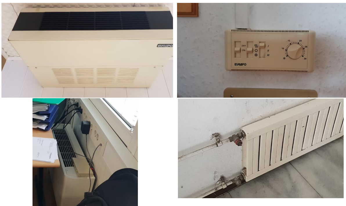
Slika 37: Konvektorski sistem za ogrevanje in hlajenje prostorov.
