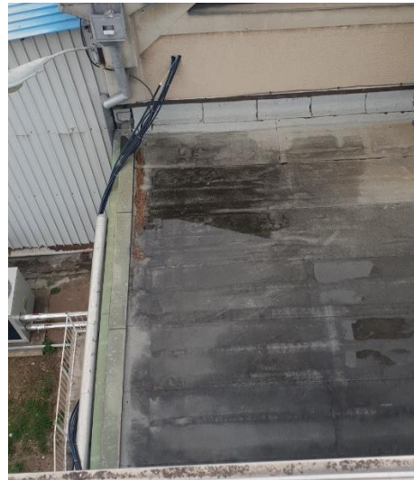
Slika 34: Streha je na obeh delih stavbe in krita z bitumensko in Sika folijo.
