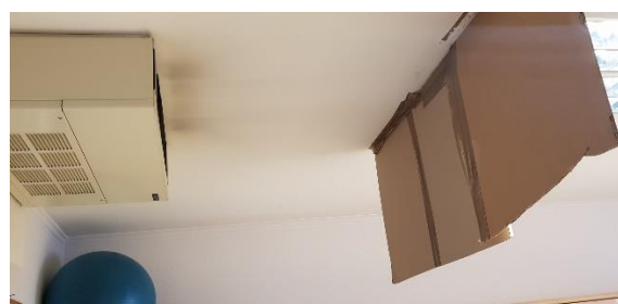
Slika 30: Neustrezna izvedba hladilnega sistema lahko privede do takšnih »rešitev«.
