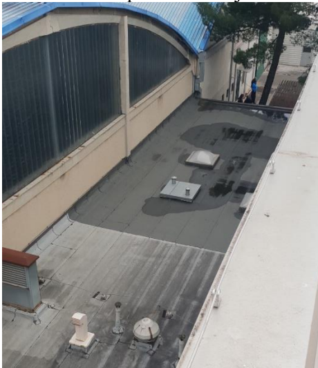
Slika 34: Streha je na obeh delih stavbe in krita z bitumensko in Sika folijo.
